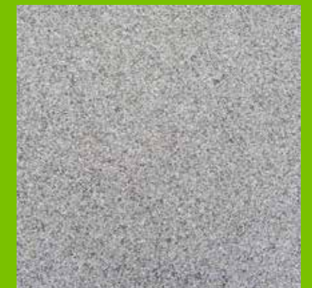
Gebundene Edelsplittbefestigung mit vollflächiger Versickerung
