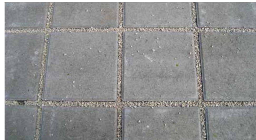
Atmungsaktive, versickerungsfähige Fugen entlasten die Kanalisation
