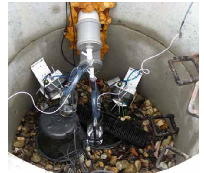
Messeinheit versickerungsfähige Wegebefestigungen
