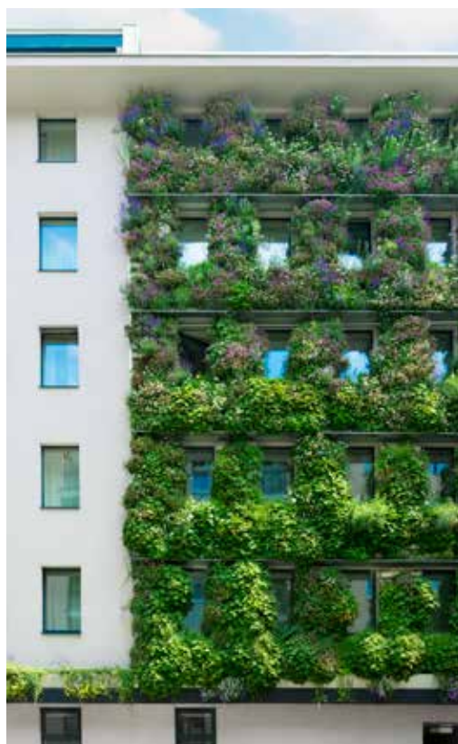
Boutiquehotel Stadthalle, 1150 Wien, Wandgrün-System Grünwand
