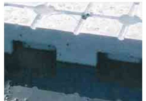
Die Lösung: ausreichend hohe Drainage mit Kapillarbruch.
