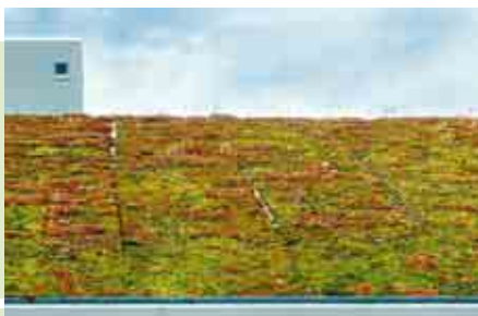
Fugen bei Vegetationsmatten
