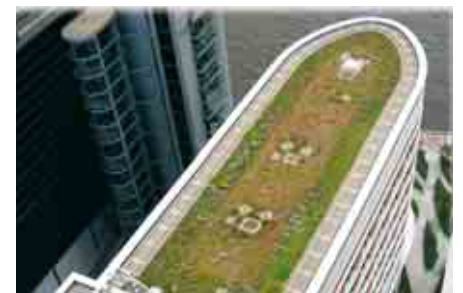
Mit vorbegrüntem Matten im Eck- und Randbereich kann bei exponierter Lage bzw. hohen Gebäuden sofort eine schützende Vegetationsdecke aufgebracht werden.
