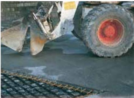
Auf Schottertragschichten (siehe vorige Seiten) bzw. auf der druckverteilenden Betontragplatte auf Floradrain® FD 60 neo ist der Einbau von Asphalttragschich-
