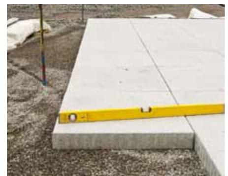
Nachdem auf der Drainageebene das Systemfiltervlies TG ausgerollt wurde, kann mit Splitt ein Planum hergestellt werden, um dem Plattenbelag ausreichende Lagestabilität zu gewährleisten.
