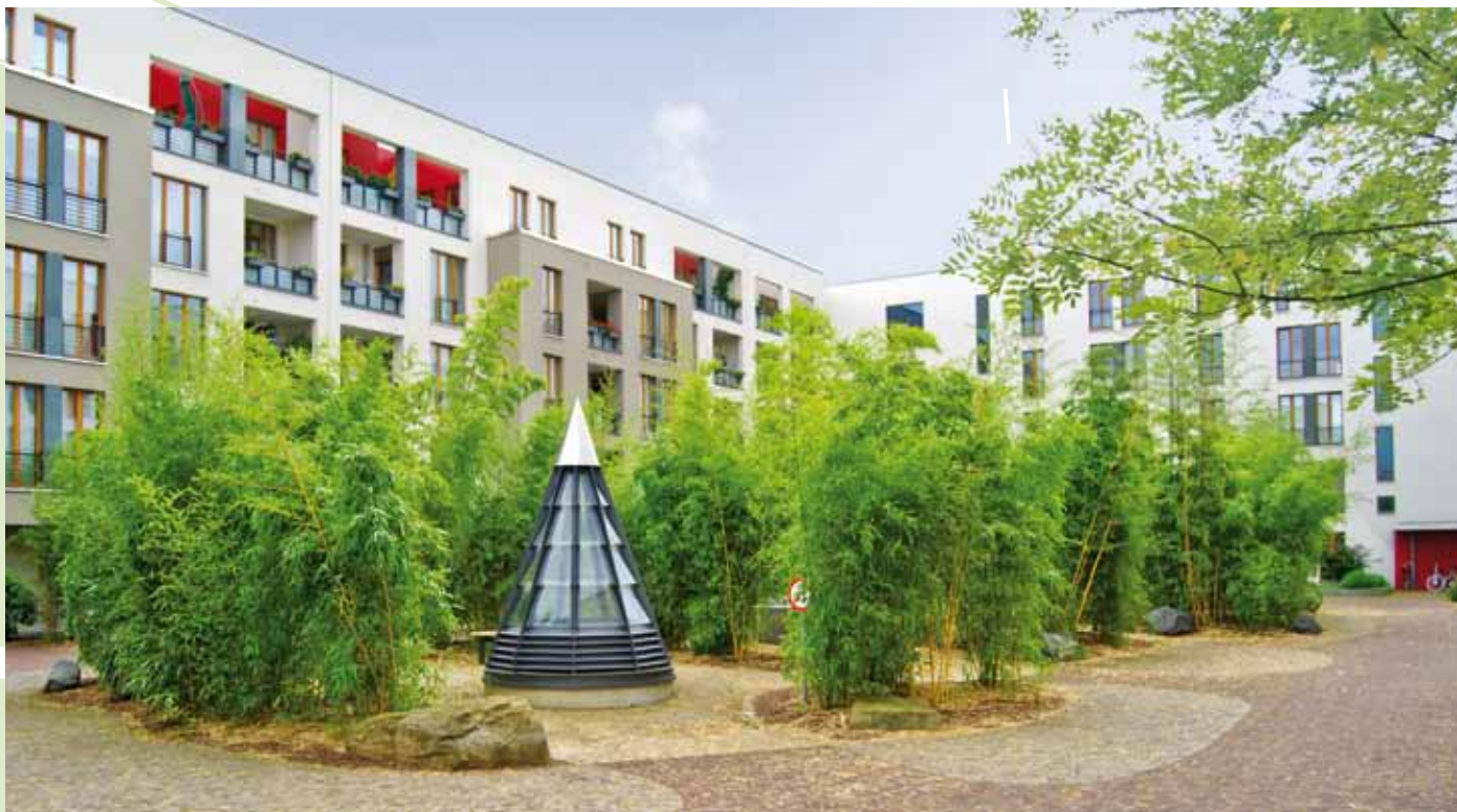
Auf der Tiefgaragendecke wurden zunächst Stabilodrain® SD 30-Platten vollflächig verlegt.
