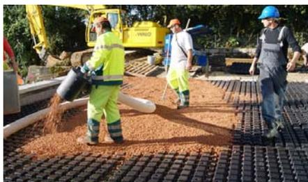
Die Drän- und Wasserspeicherelemente Floradrain® FD 60 wurden mit Zincolit® Plus verfüllt.
