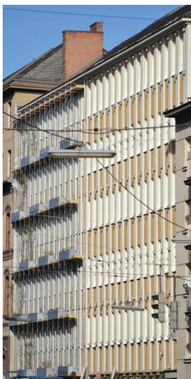
Denn es galt eine radikale, stark vertikal gegliederte Süd/West-Fassade aus den 1960-er Jahren thermisch zu sanieren und mit einer neuen „grünen“ Funktion bzw. Struktur zu kombinieren. Die innovative Antwort auf die Fragestellung entwickelte sich in der interdisziplinären Zusammenarbeit von Landschaftsplanung, Architektur, Statik und Bewässerungstechnik.
