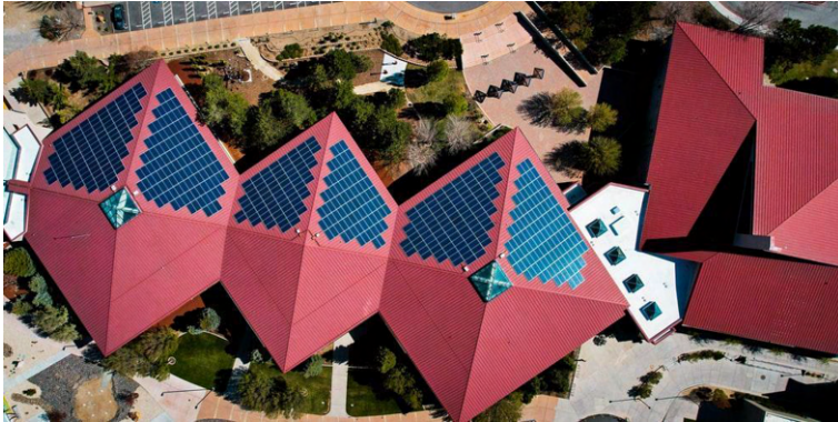
Abbildung 94: Photovoltaikanlagen auf Gebäuden. Quelle: https://unsplash.com/@mannyb
