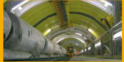
TUNNELBAU UND BAUWERKSABDICHTUNG
