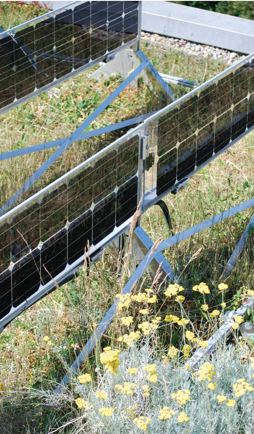
Solargründach bifaziale Solarmodule auf Biodiversitätsgründach (C) GRÜNSTATGRAU
