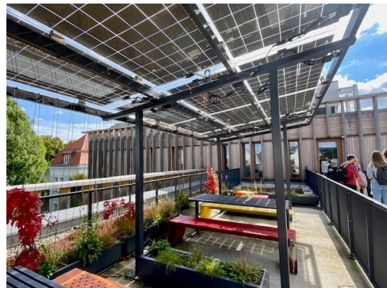
Abbildung 46: PV-Dachgarten (Irene Zluwa, BOKU) Abbildung 47: Pergolen mit integrierter PV
