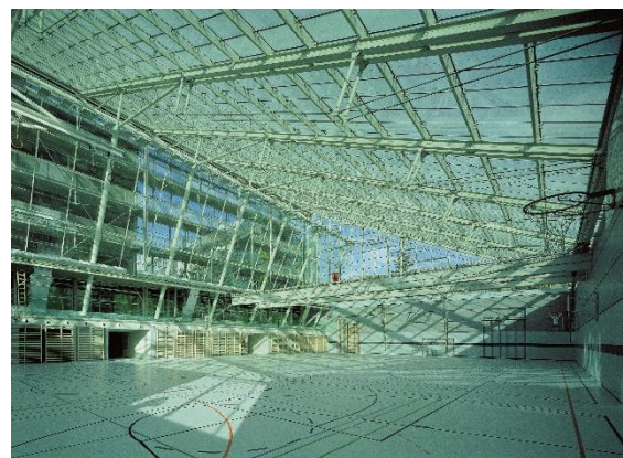
Abbildung 2: Dreifachturnhalle, Foto: Mischa Erben
