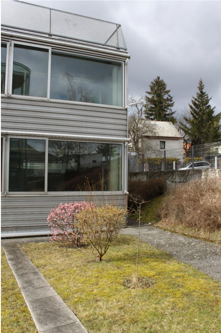
Abbildung 12: Aufnahme Fassade Klassentrakt, Februar 2021
