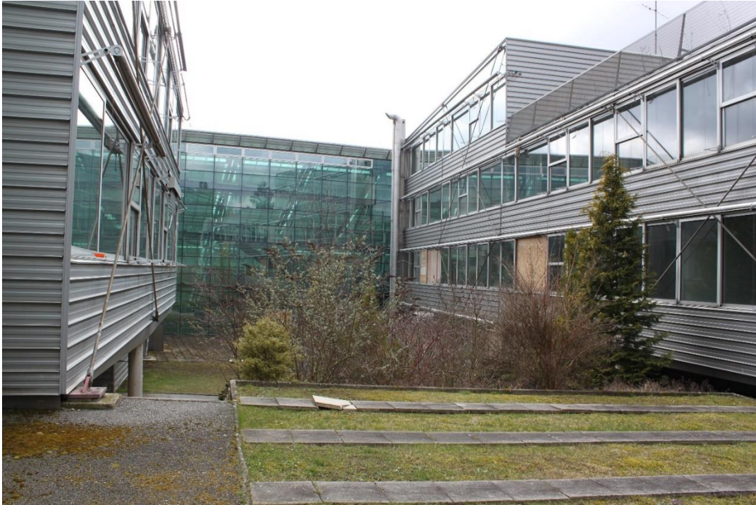
Abbildung 11: Aufnahme Innenhof terrassiert und Fassaden Klassentrakte, Februar 2021
