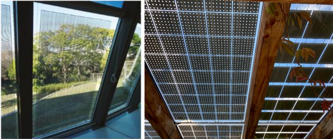
Abbildung 52: semitransparente Module Abbildung 51: perforierte und Standardmodule
