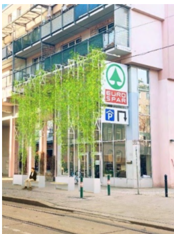
Abbildung 6: Entwurf I mit Primärkonstruktion aus T-Profilen für Standort KREUZGASSE | WIEN. © RATAPLAN, 2024.
