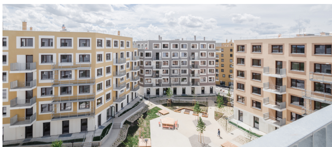
WOHNQUARTIER SEESTADT ASPERN/ WIEN/ 2015
