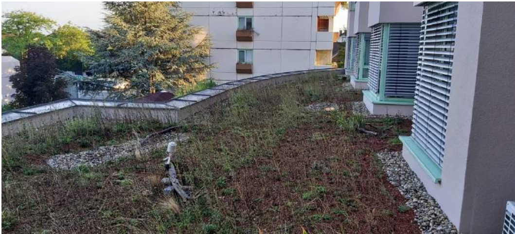
Abbildung 33: Die Versuchsfäche des Vordaches des PBZ Tulln nach der Begrünung
