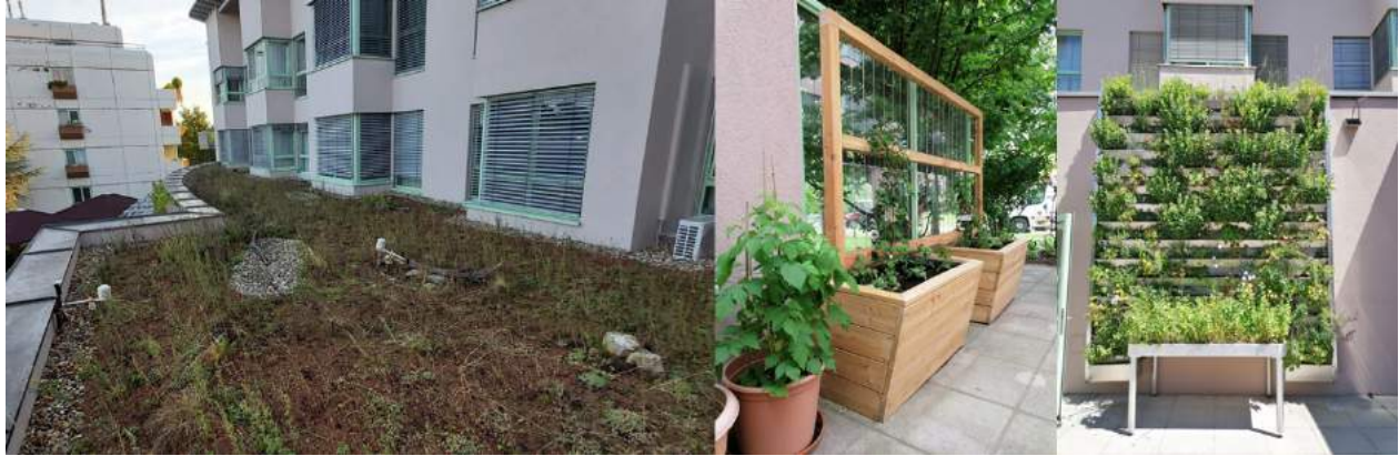
Dachbegrünung, Hochbeete mit Rankhilfen und Grünwand mit Naschtisch im Außenbereich des PBZ Tulln, 2022
