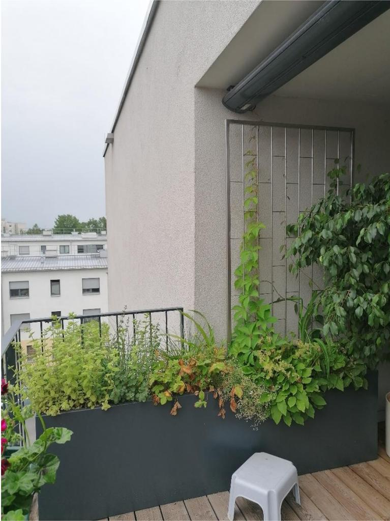
Abbildung 18: Troggebundene Vertikalbegrünung auf einem Balkon des PBZ Wolkersdorf
