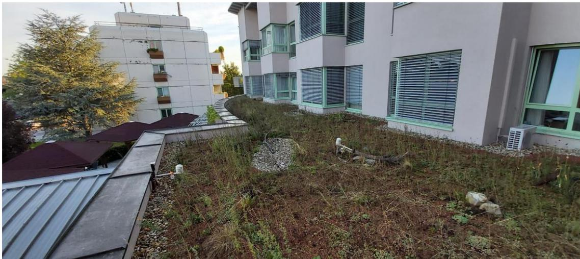
Abbildung 21: Extensive Dachbegrünung auf einem Vordach des PBZ Tulln
