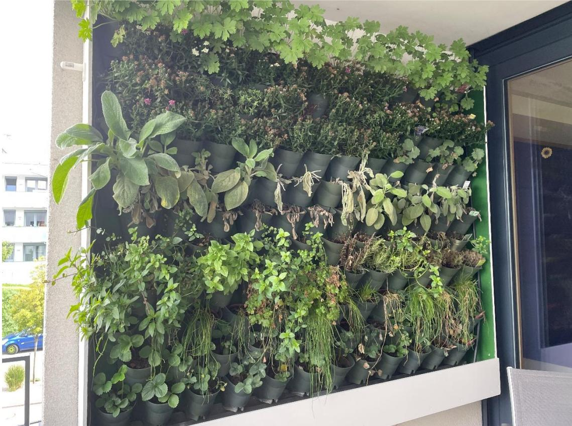
Abbildung 19: Fassadengebundene Begrünung auf einem Balkon des PBZ Wolkersdorf
