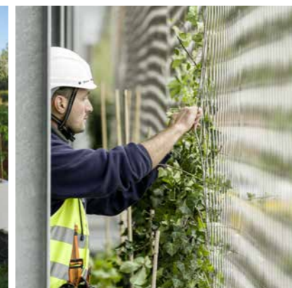
Fachgerechtes Einarbeiten der Pflanzen in die Rankhilfe © Stefan Schilling
