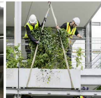
Montage der Pflanzgefäße am Traggerüst
