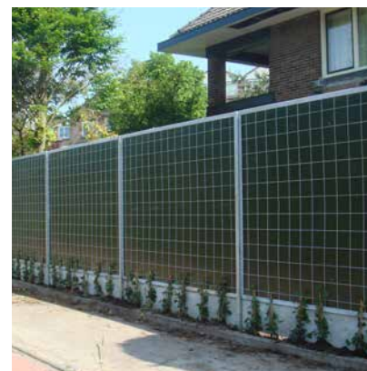
'Helix® Pura KL' Schalldämmung: R_w = 29 \text{ dB(a)} (gemäß NEN I 793-2 in Kategorie B3), keine Schallabsorption
