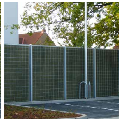
'Helix® Pura NR' ... Schallabsorption: D_{LA} = 8 \text{ dB(a)} (gemäß NEN I 793-2 in Kategorie B3)
