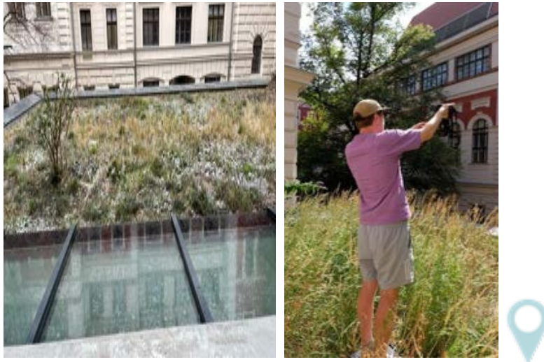
Abbildung 159: Café Mendl, links: extensive Dachbegrünung - 2023, rechts: Messaufnahmen - 2024 (©IBLB).
