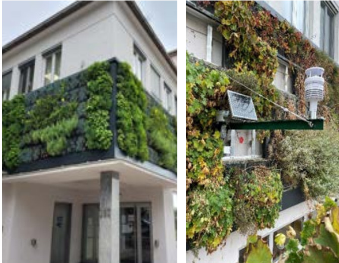
Abbildung 30: Wien Energie, links: Frontansicht der modularen Grünfassade (Süd-Ost), rechts: Installation der Dauermesssensorik (©IBLB).
