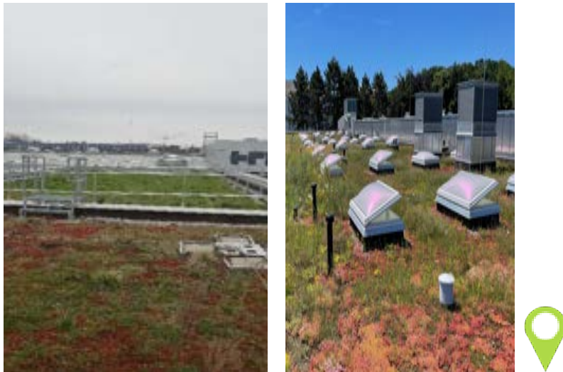
Abbildung 117: HTL St. Pölten extensiv, links: extensive sowie angrenzendes reduziert-intensive Dachbegrünung, rechts: Strahlungssensor in Sedum-Bestand (©IBLB).
