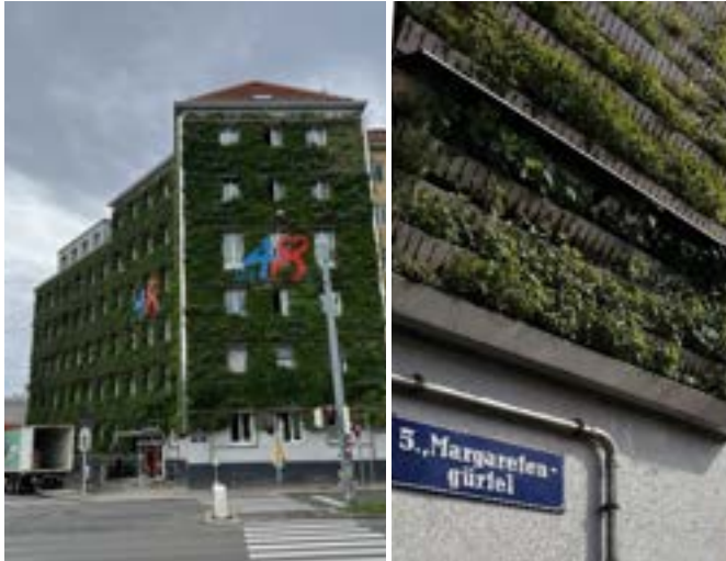
Abbildung 50: MA48 Gürtel, links: Frontansicht wandgebundene Fassadenbegrünung (Süd-seitig), rechts: Wannensystem (©IBLB).
