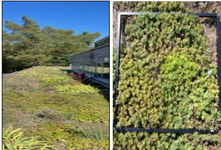
Abbildung 154: Die Garten Tulln, links: extensive Begrünung, rechts: Messrahmen mit Sedum sp. (©IBLB).
