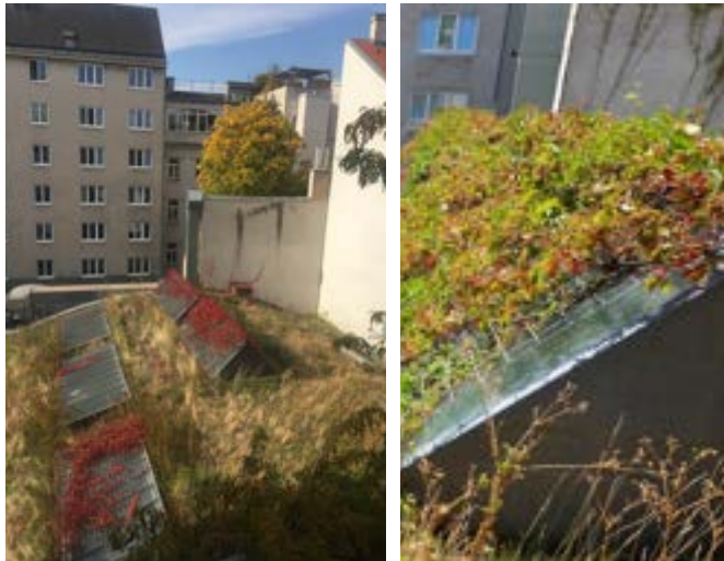
Abbildung 148: Klangforum, links: reduziert-intensive Begrünung mit umliegenden Gebäuden, rechts: Parthenocissus tricuspidata auf Abstandhalter über Oberlichtern (©IBLB).
