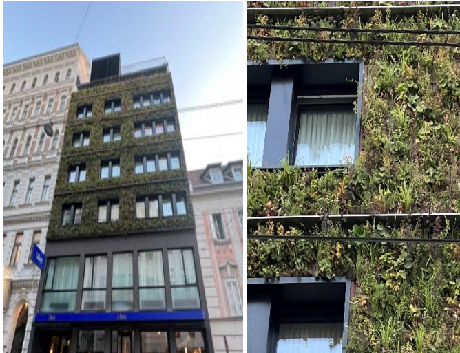
Abbildung 88: Hotel Gilbert, links: Frontansicht der modularen Fassadenbegrünung (Ostseite), rechts: Nahaufnahme biodiverser Begrünung (©Hotel Gilbert).
